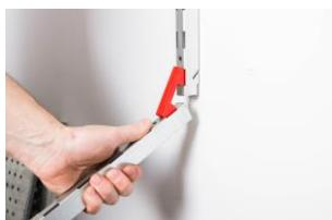
**3 – распределяем Вертикальные несущие по длине Шины согласно планировке** стеллажной конструкции – удобно использовать для этого ПерфоПанели соответствующего размера (600 или 800 мм), если они есть в Вашем комплекте, если нет, используем рулетку;
